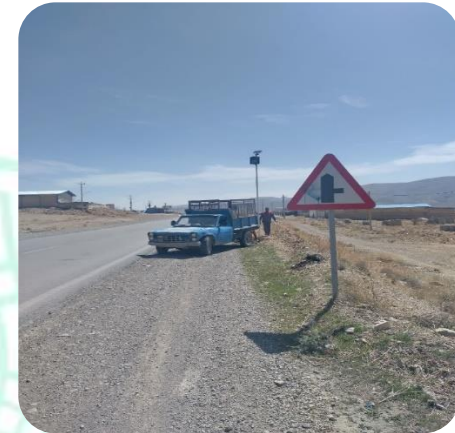
(نصب تابلو راهنمایی و رانندگی)
