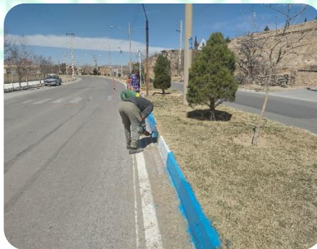
(رنگ آمیزی بلوار)
