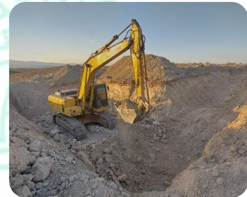
(حفر ترانشه سایت زباله)
