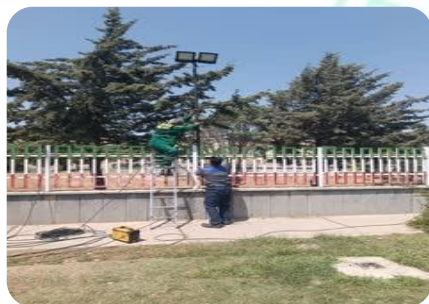
نصب پروژکتور پارک بنفشه
